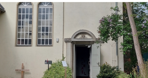
10 Außenanstrich St. Michael Kirche
